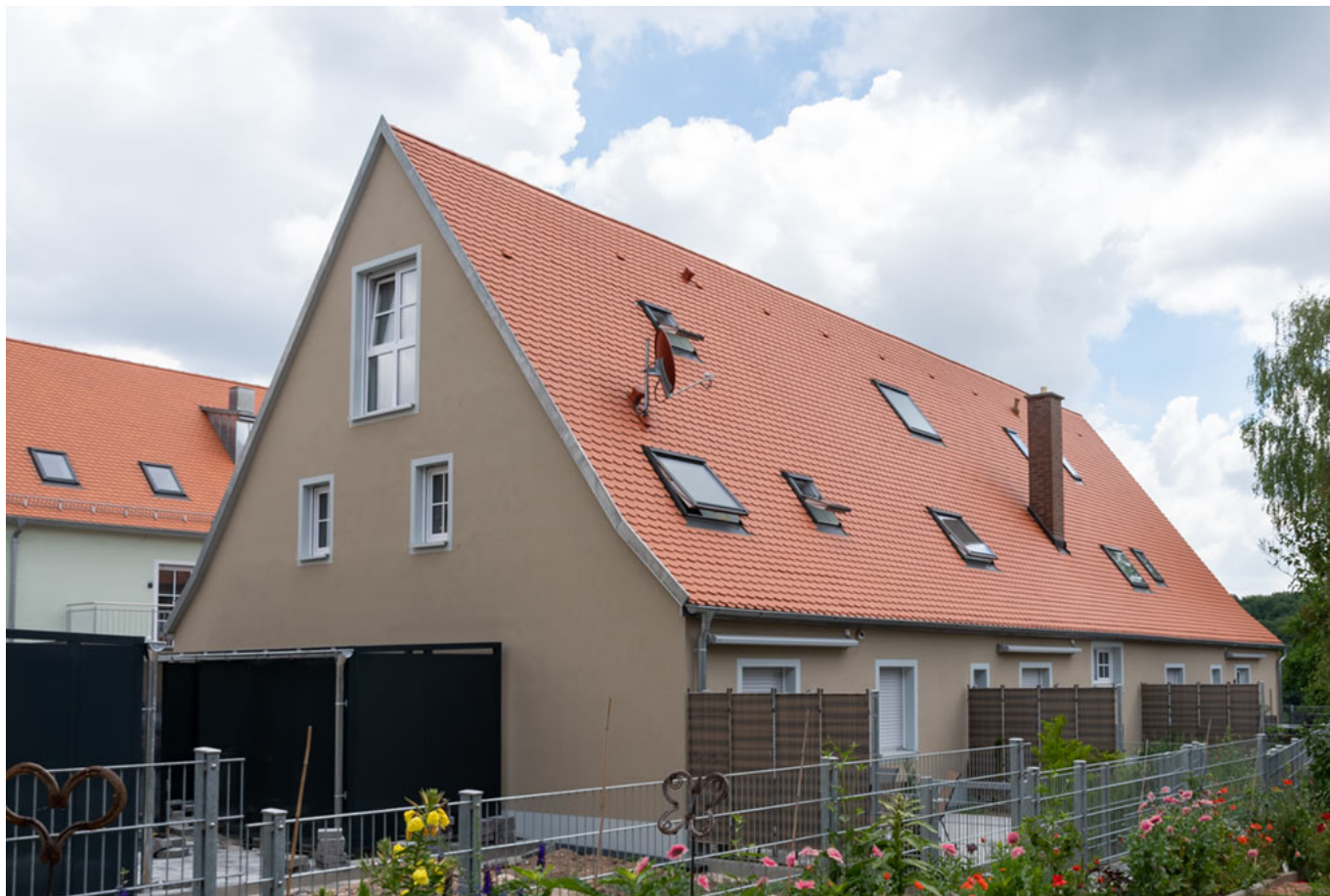
Das Gebäude nach der Kernsanierung: aus den ehemaligen Ferienwohnungen sind sieben neue Wohnungen entstanden
