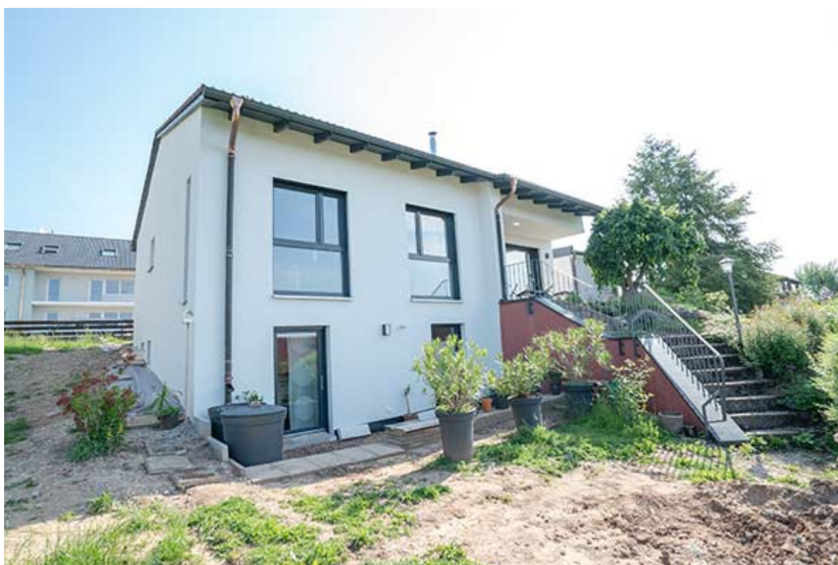
Haus Südseite vorher
