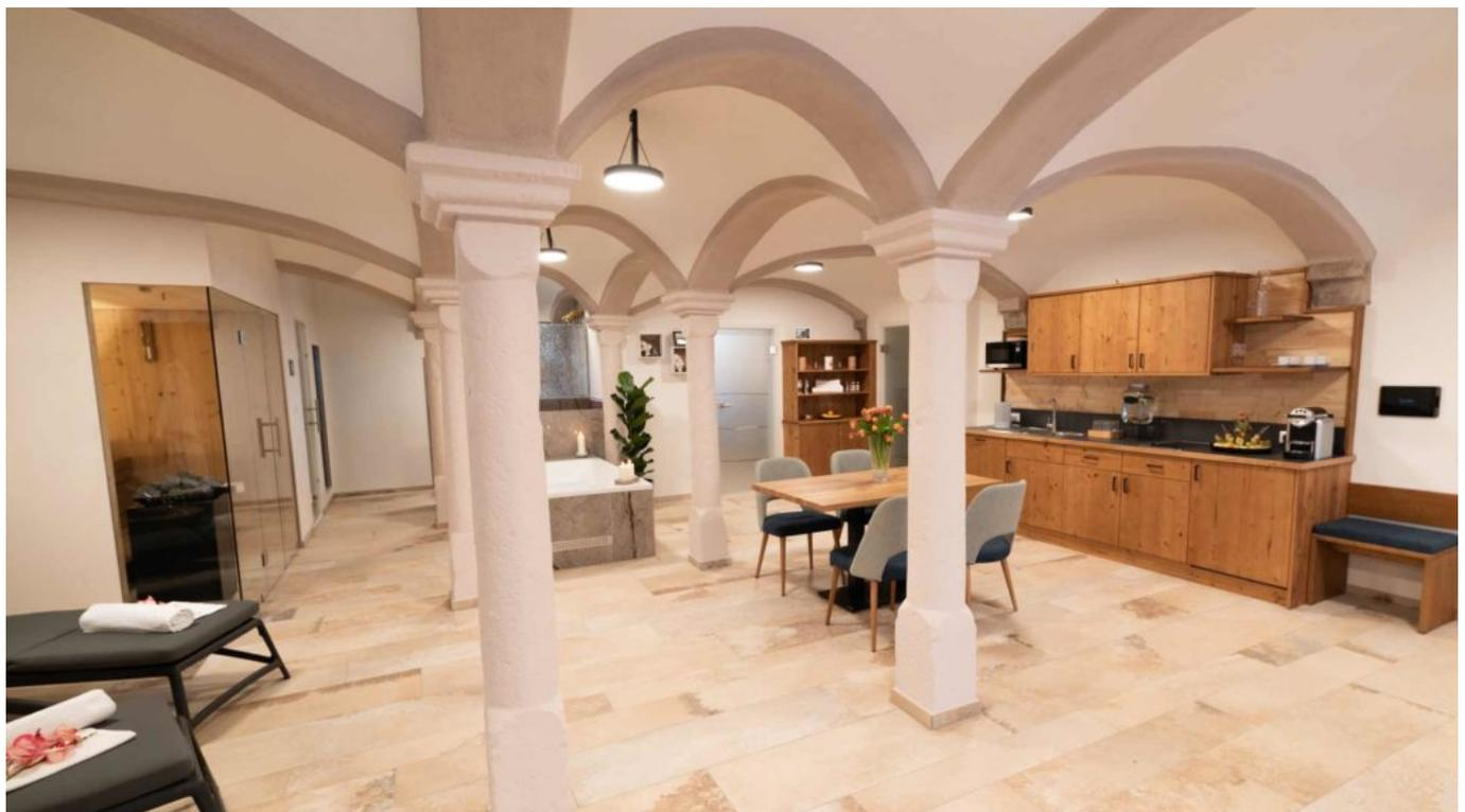
Ebenso konnte ein stilvolles, auf acht Steinsäulen gemauertes böhmische Gewölbe vollständig erhalten bleiben und wurde an den Stellen, an denen der Zahn der Zeit schon zu arg genagt hat, durch Fachfirmen hervorragend in Schuss gebracht. In diesem Gewölbe-Raum wurde der größere Wellnessbereich untergebracht, der auch als Ferienwohnung genutzt werden kann. In diesem
