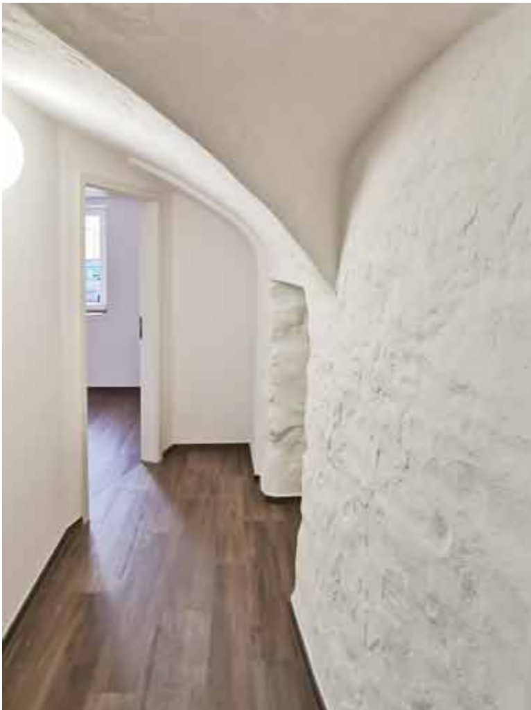
Das Gewölbe im Erdgeschoss konnte erhalten werden
