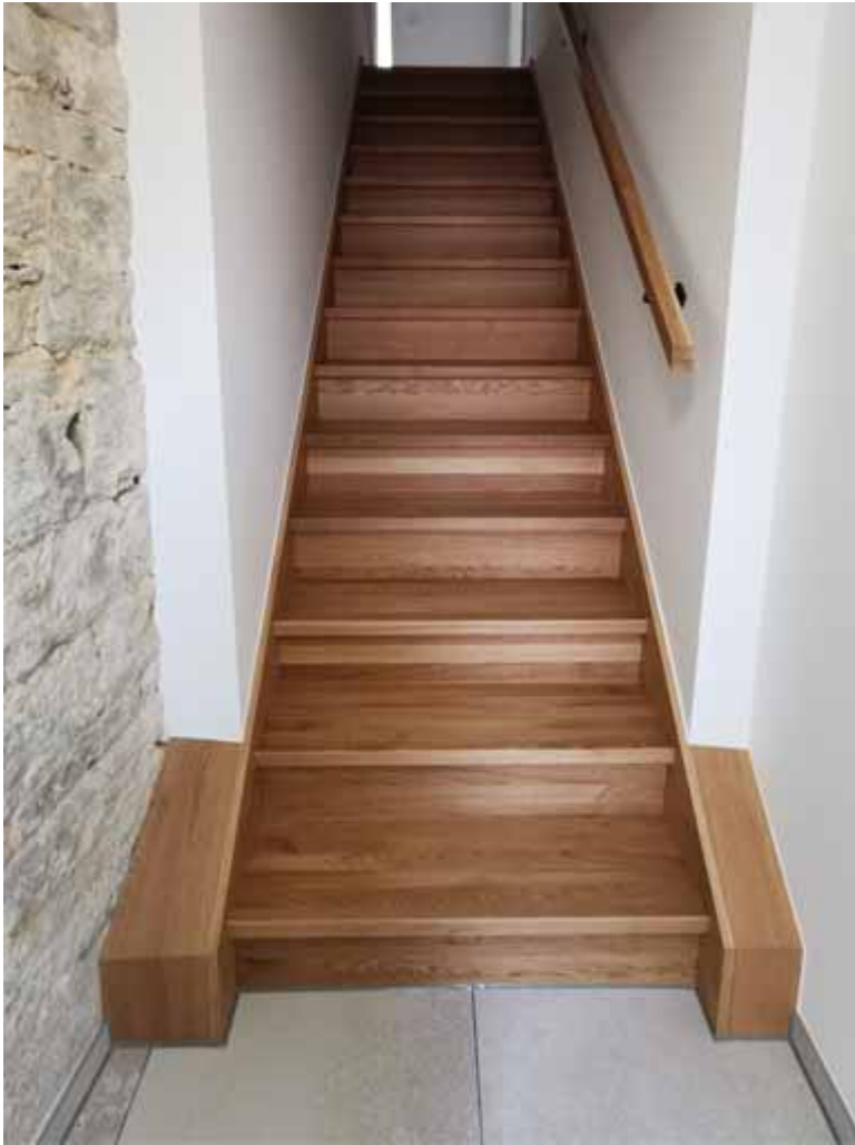
Die neue Massivholztreppe aus Eiche führt ins Obergeschoss
